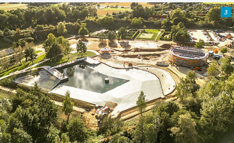
2 | Beckenbau in Hybridbauweise, Fotos: Gregor Zielasko
