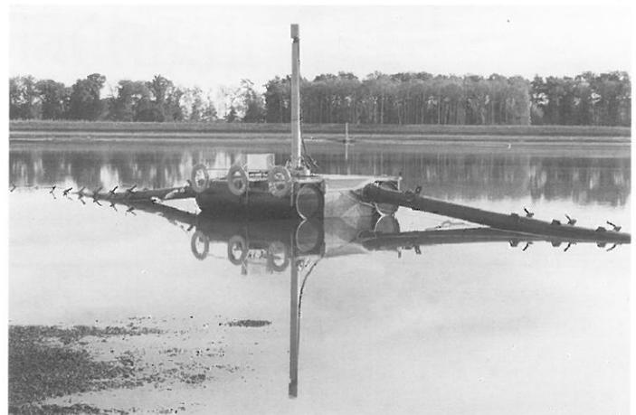
4: Rotationsbelüfter im fast entleerten Abwasserbecken. Hier Drehpol mit Pumpensumpf und Druckrohrstränge
