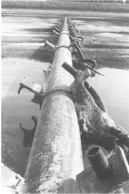
◀ 5: Ausschnitt eines Belüfterrohrstranges im entleerten Abwasserbecken. Die Ejektoren sind elastisch befestigt und bei Bedarf mittels Schnellkupplungen lösbar
